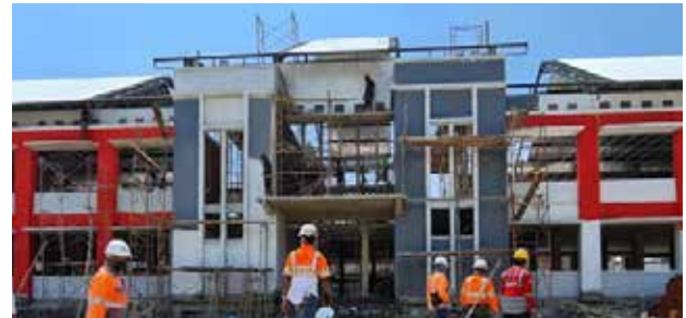
Pembangunan lapas di Nusakambangan Prison construction in Nusakambangan
