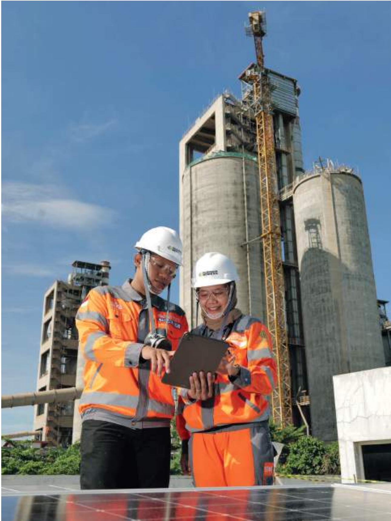
Pembangkit listrik tenaga surya Pabrik Tuban, salah satu inisiatif transisi energi berkelanjutan Perseroan. Tuban Plant solar power plant, one of the Company's sustainable energy transition initiatives.
