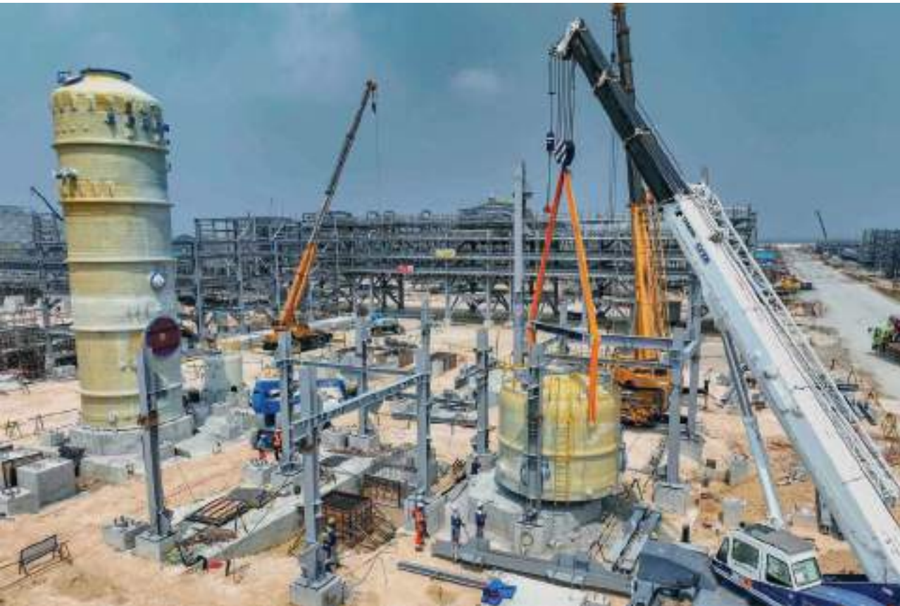
Pembangunan Smelter Manyar PT Freeport Indonesia, fasilitas pengolahan tembaga terbesar di dunia, yang didukung oleh Solusi Bangun Indonesia. Construction of PT Freeport Indonesia's Manyar Smelter, the world's largest copper processing facility, supported by Solusi Bangun Indonesia.
